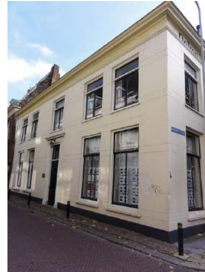
Pand op de hoek van de Binnenmolenstraat. Foto: voorgevel Rijksdienst voor het Cultureel Erfgoed. -29 September 2010
