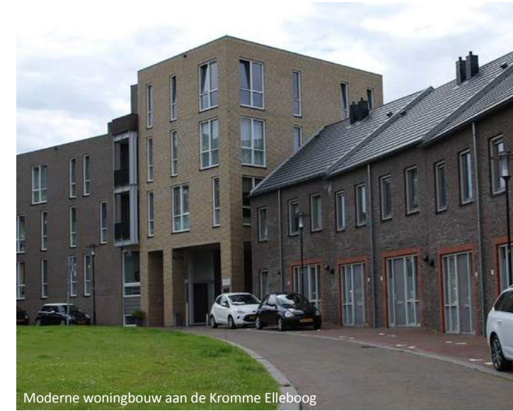
Moderne woningbouw aan de Kromme Elleboog
