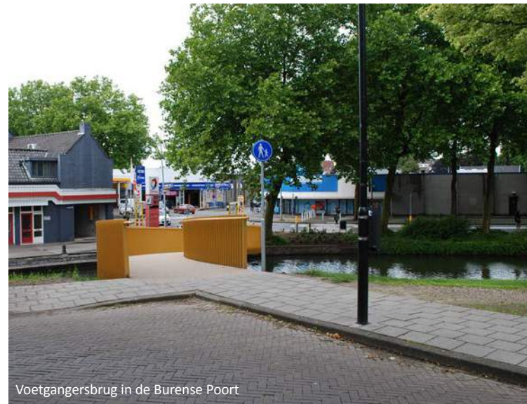
Voetgangersbrug in de Burense Poort
