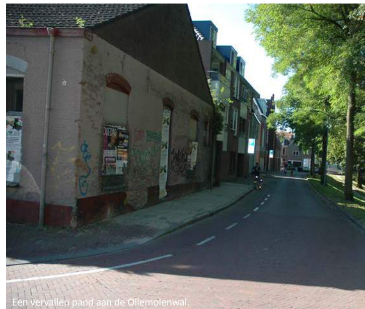
Een vervallen pand aan de Oliemolenwal
